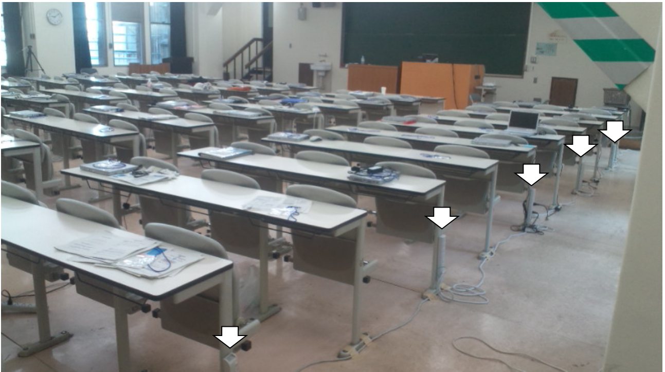
図 14. コンセントの配置。3人掛けの机 1 つにつき AC タップ 1 個を配置した。
